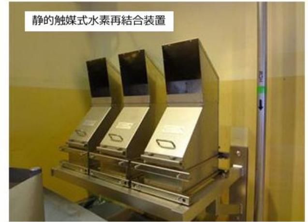
静的触媒式水素再結合装置
