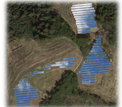
メガソーラー建設地
